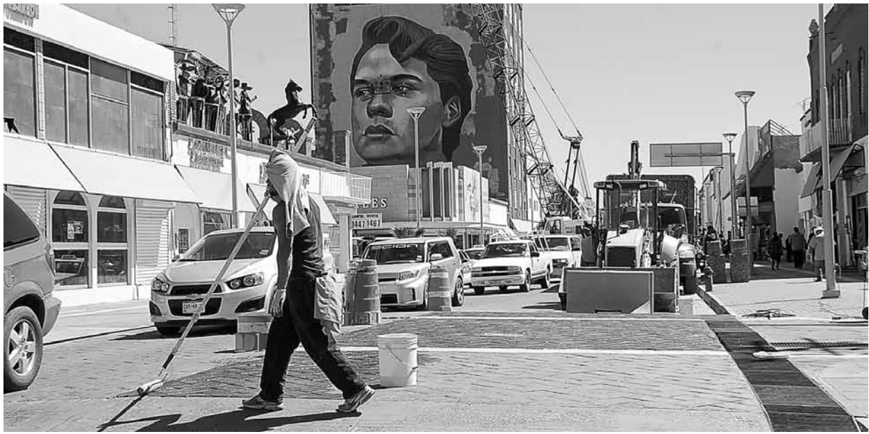
Obras en la avenida Juárez.
